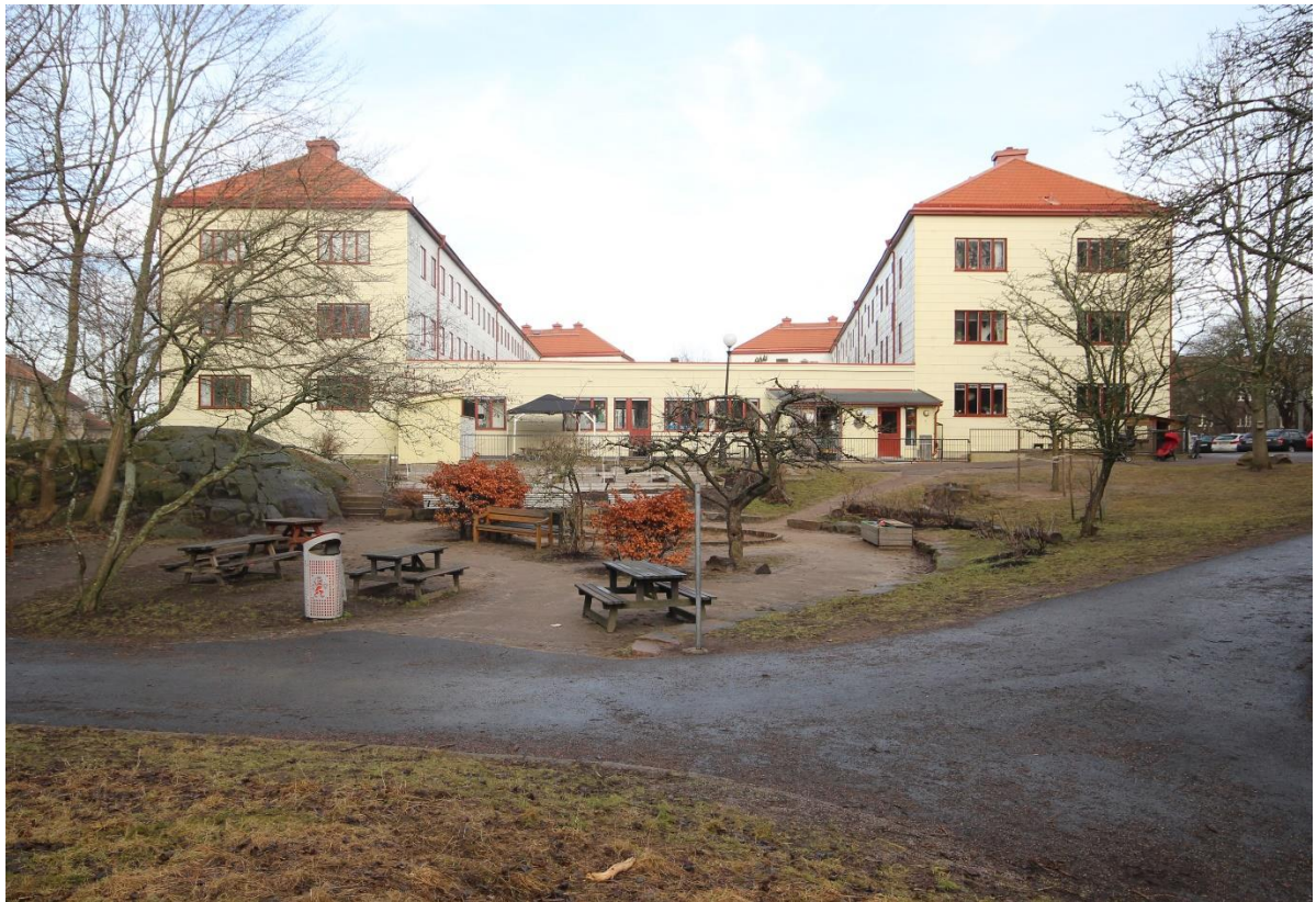
Mot söder är byggnaderna Paradisgatan 27 och 29 sammanbyggda av en enplansbyggnad. Gavlarna med fyllningsfönster vetter mot Slottsskogen.
