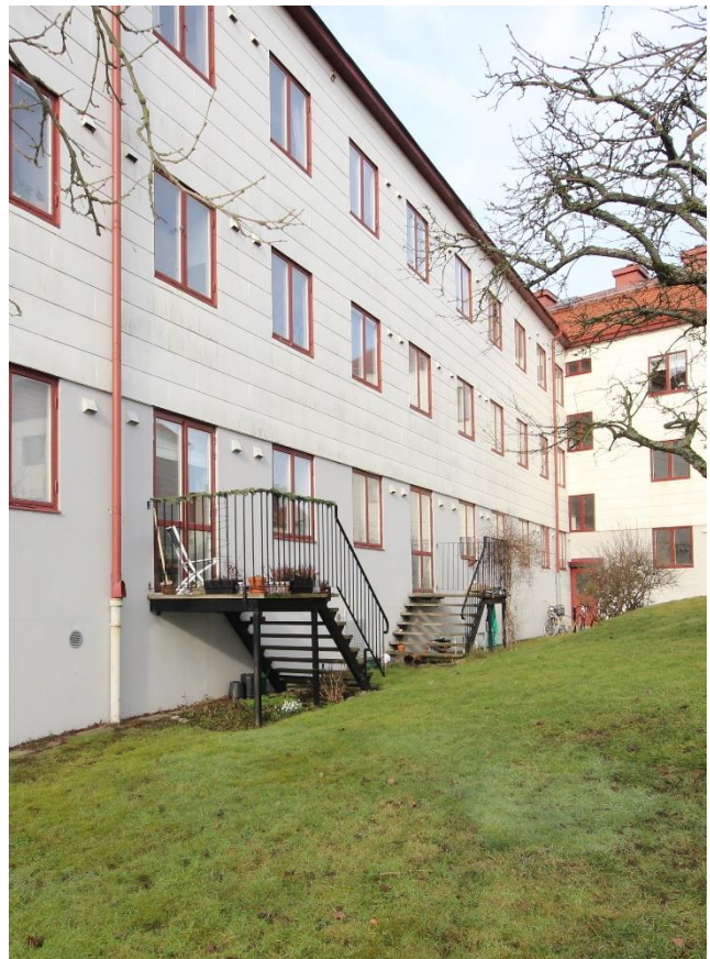
En senare genomförd förändring är de trappor som leder från lägenheter på första våningen till den övre gården.
