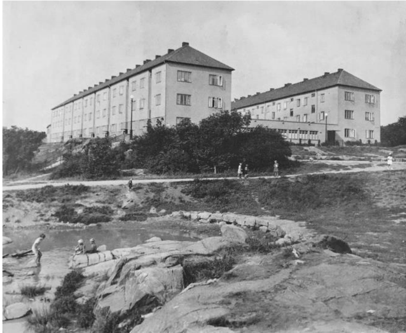
Kv. Betel från söder.
